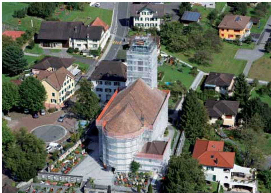
Sanierung der Fassade der Pfarrkirche St. Peter und Paul im Jahr 2011.
